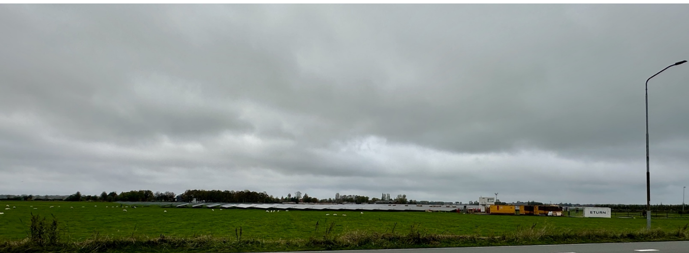
Figuur 4.4. Foto vanaf de Geesterweg van het zonnepark in oktober 2025, vanaf ongeveer de zelfde locatie als Figuur 4.3. De containers rechts naast het zonnepark zijn tijdelijk en worden verwijderd na afloop van de bouw
